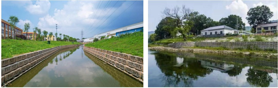
图 2-9 阶梯式生态框挡墙护岸实景图
