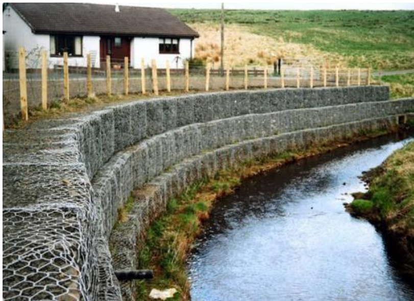
图 2-8 宾格石笼挡墙实景图
