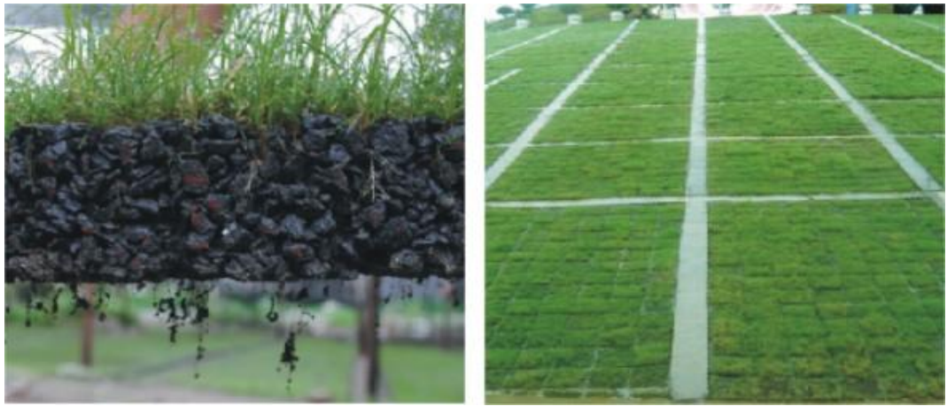
图 2-5 生态砼护坡实景图
