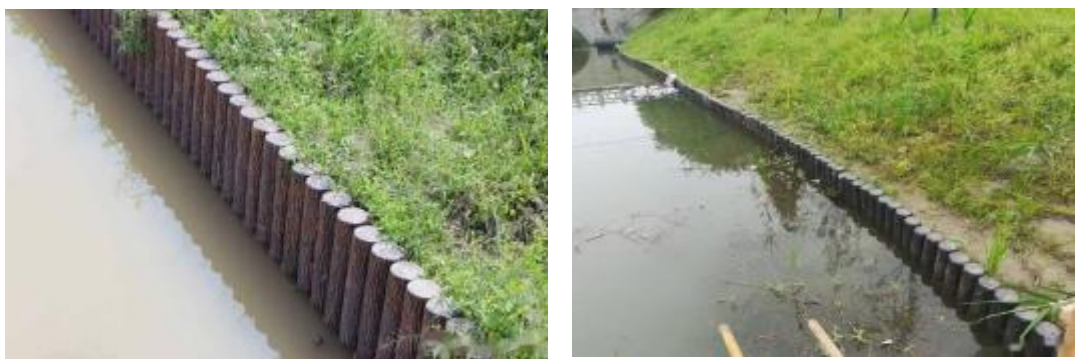
图 2-10 桩型护坡实景图
